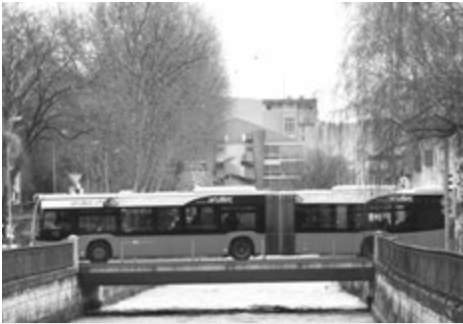
Neben der alten gebaut: Die neue Schüss-Brücke.
